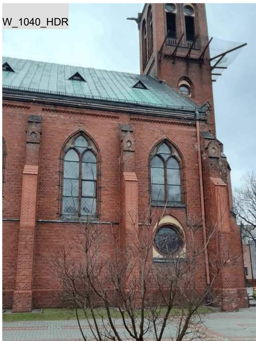
S-DJI_121145_PO-02 Nowe cegły klinkierowe jak i cegły zniszczone do usunięcia i zastąpienia cegłami półklinkierowymi dedykowanymi na inwestycję
